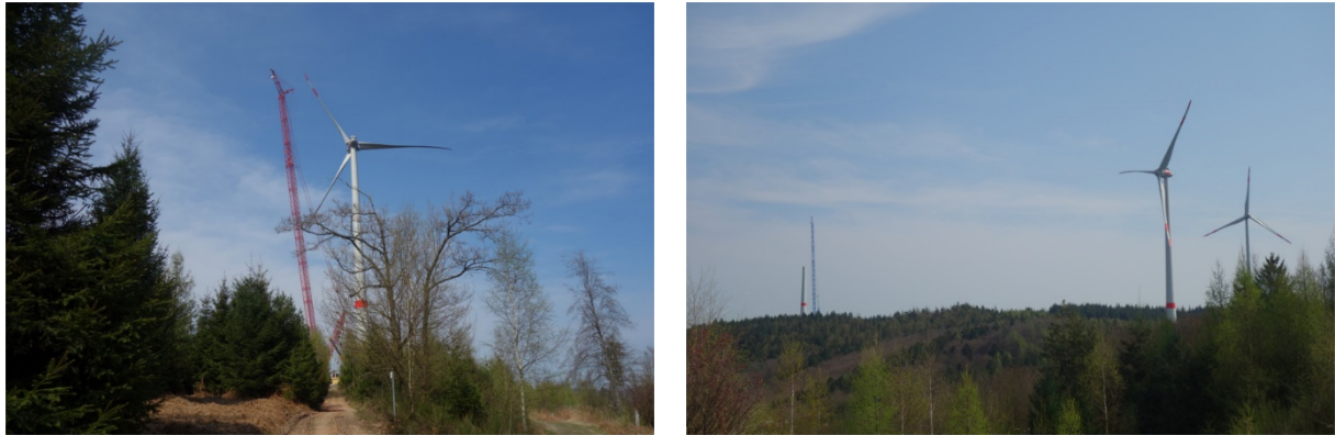
Abbildung 1: Fotos vom Greiner Eck während der Bauphase im Frühjahr 2017.
