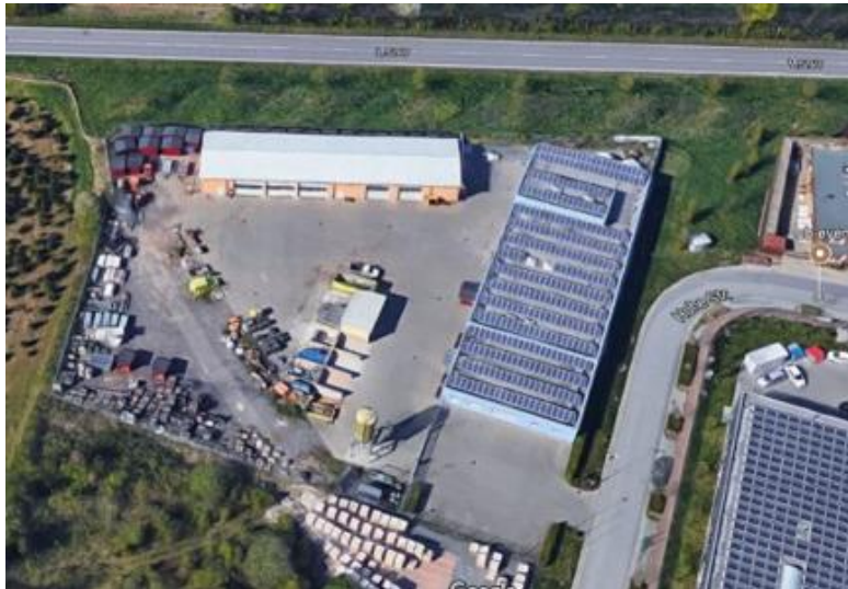
Abbildung 1: Bauhof Ladenburg (Quelle: Google Earth)
