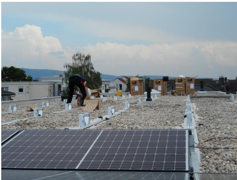
Abbildung 3: Die Anlage in Eppelheim im Bau
