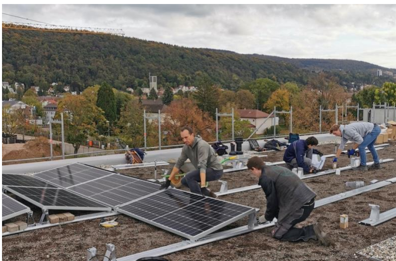
Abbildung 2: Das Team der HEG beim Bau der Solaranlage auf dem Dach der Baugruppe WoGe in der Südstadt
