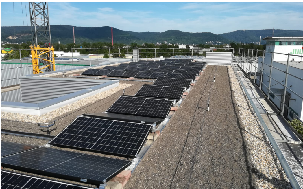
Bilder vom Bau der Anlage (Quelle: EvO).
