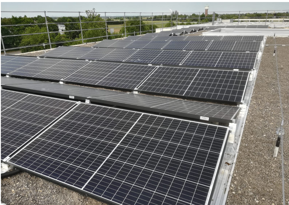
Die fertige Solaranlage auf dem Dach des Jedermann-Verlags (Quelle: EVO).
