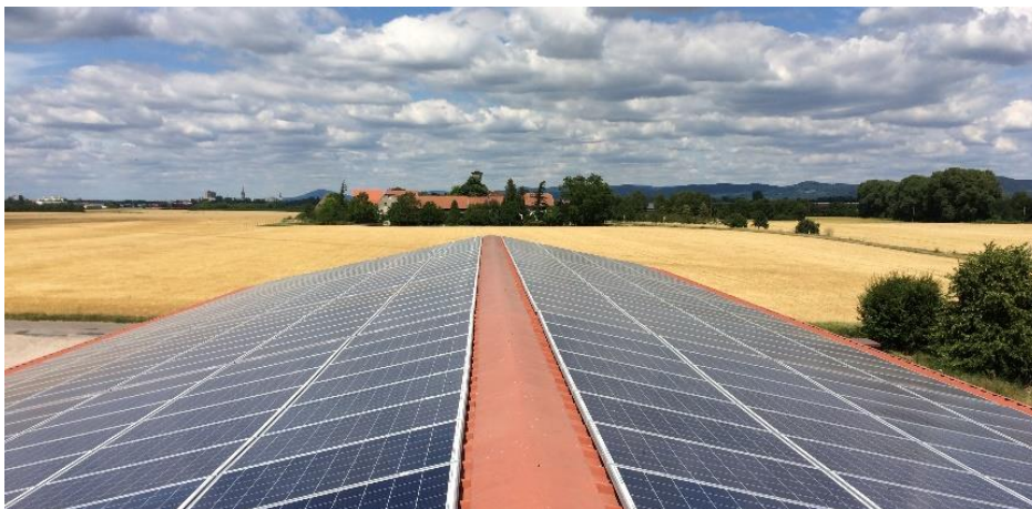
Abbildung 1: Die fertige Photovoltaikanlage auf dem Dach der Reitanlage in Straßenheim (Quelle: HEG)
